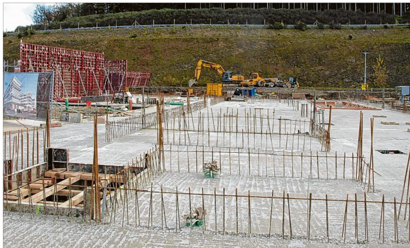
Die Fundamente sind bereit: Jetzt kann im Gewerbegebiet Martinshardt der Hochbau für das Hightech-Zentrum starten.
