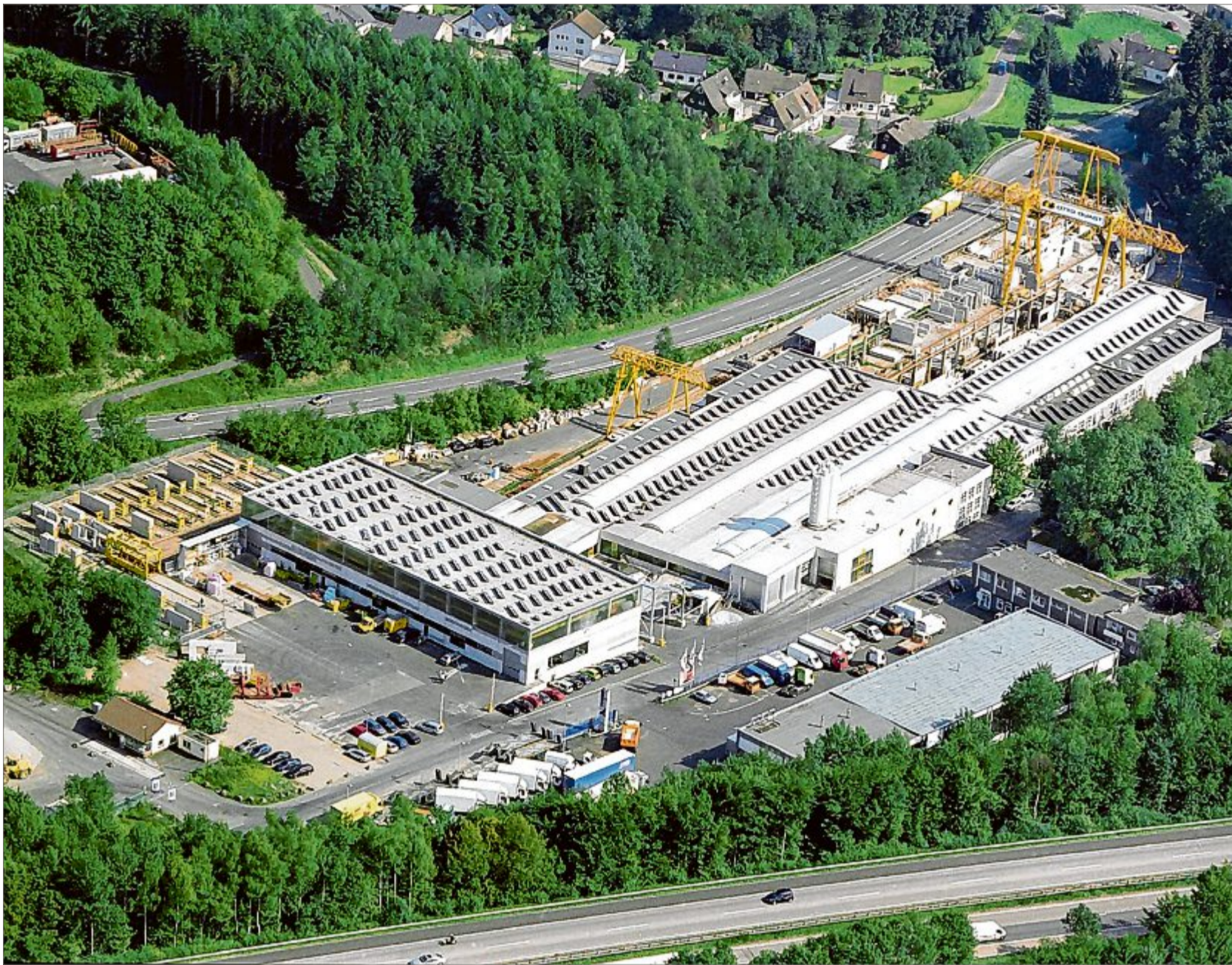
1966 baute das Unternehmen das Werk Fertigungsbau Lindenberg, in dem seither Stahlbeton- und Spannbetonfertigteile gefertigt werden. Bis heute ein wichtiger Baustein der unternehmerischen Strukturen bei Otto Quast. Fotos: Unternehmen
