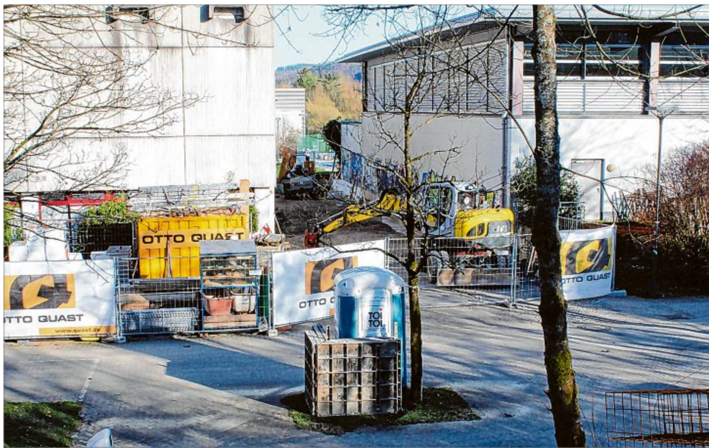
Neben der Baustelleneinrichtung ist an der Schnittstelle der beiden Kreuztaler Sporthallen in der Stählerwiese bereits mit vorbereitenden Außenarbeiten begonnen worden. Nun soll das Projekt sofort in Angriff genommen werden. Fotos (2): Jost-Rainer Georg
