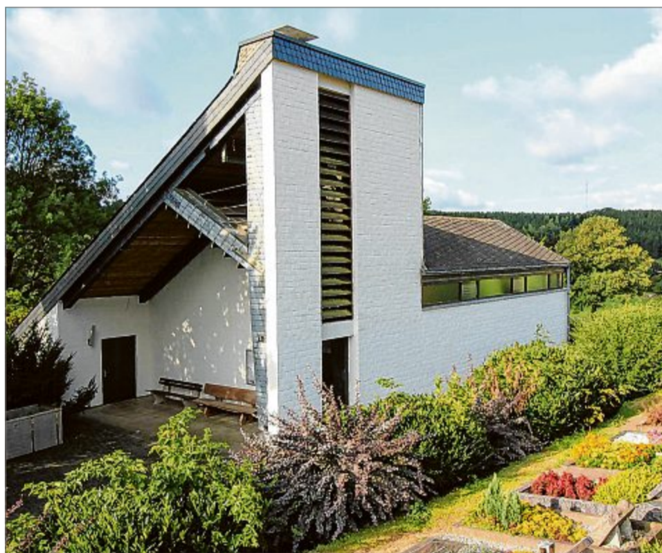
Die Friedhofshalle in Helberhausen – eigentlich ein Ort für würdevolle Bestattungen. Das von der Stadt Hilchenbach beauftragte Reinigungsunternehmen kam seiner Aufgabe aber zuletzt nicht nach. Das sorgte bei Trauernden für viel Ärger. Foto: Christian Schwermer
