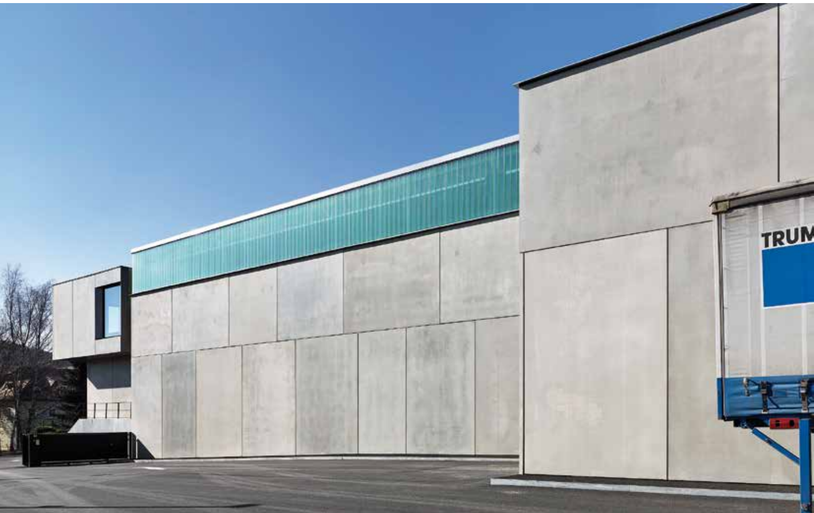
Abb. 7 Die Nordfassade wurde mit großformatigen Betonfertigteilen weitgehend geschlossen
