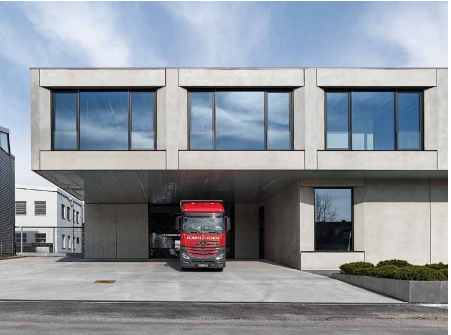
Abb. 8 Die Betonfertigteile weisen abgeschrägte Fensterlaibungen auf, die sich von der glatten Hallenverkleidung absetzen
