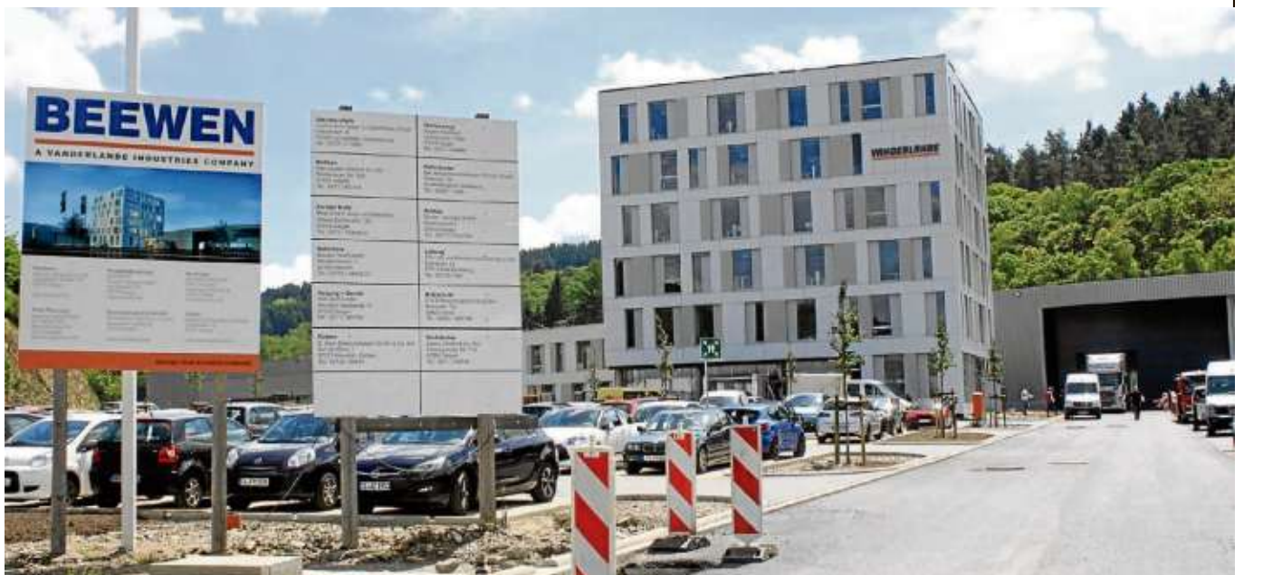
15 Monate hat die Errichtung des neuen Bürogebäudes und der angrenzenden Produktionshalle im Oberen Leimbachtal gedauert. Foto: Ann Kathrin Müsse
