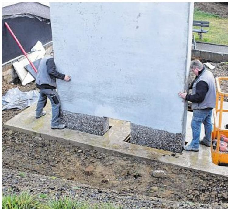
Wie Lego in groß: Die 25 Tonnen schwere Platte aus Beton wurde in Aussparungen im Fundament geschoben und dann verkeilt.
