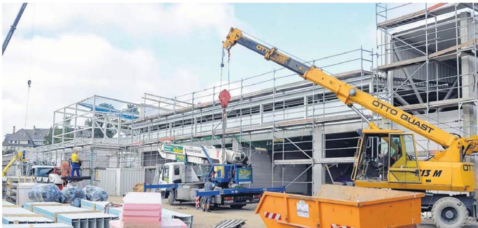
An der Bahnhofstraße in Auerbach baut Aldi seinen neuen Markt.
