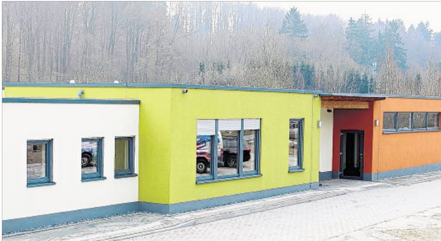
Der farbenfrohe Flachbau in der Hengsbachstraße bietet nicht nur mehr Platz, sondern erfüllt auch modernste Anforderungen.
