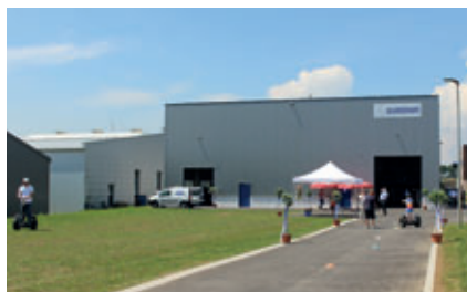
Auf der noch freien Fläche des Grundstücks soll der zweite Bauabschnitt realisiert werden
