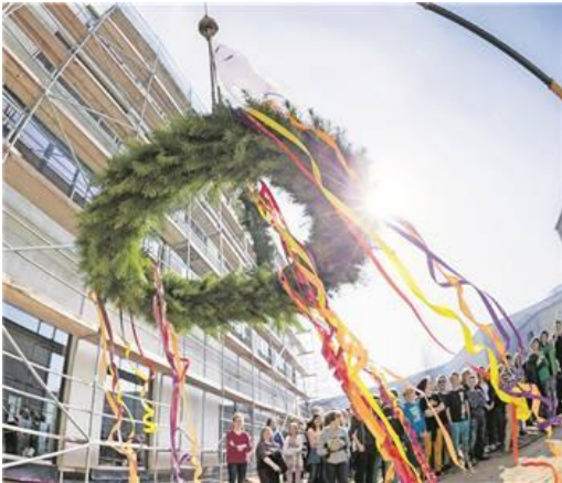
Richtkranz im Sonnenschein: 20 Jahre gibt es die Freie Evangelische Schule bereits. Im Juli soll der Neubau von Grund- und Mittelschule fertig sein. Foto: Jörn Haufe
