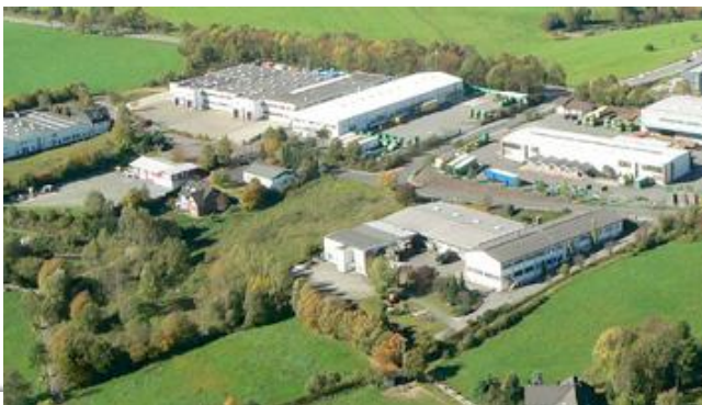
Die Luftaufnahme zeigt vorne rechts den vorhandenen Werkstattkomplex der Behinderten-Werkstätten Oberberg (BWO) im Gewerbegebiet Lichtenberg. Links daneben soll bis 2015 der Erweiterungsbau entstehen.
