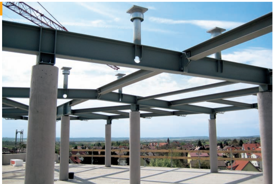
Dachtragkonstruktion auf Ortbeton-Rundstützen.
