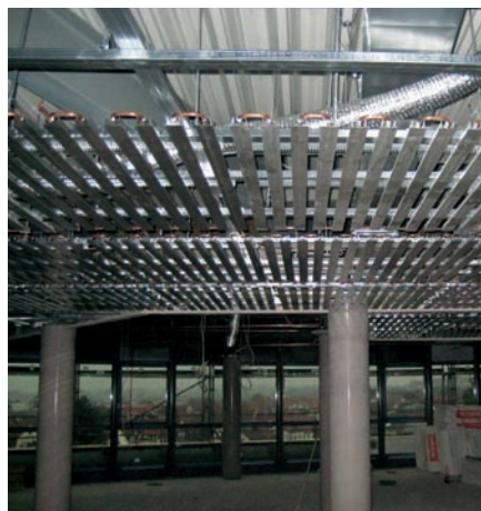
Kühldecken mit Begleittlüftung in den Hohlraumböden (Abb. links), Auskragungen für den stationären Sonnenschutz (Abb. rechts).
