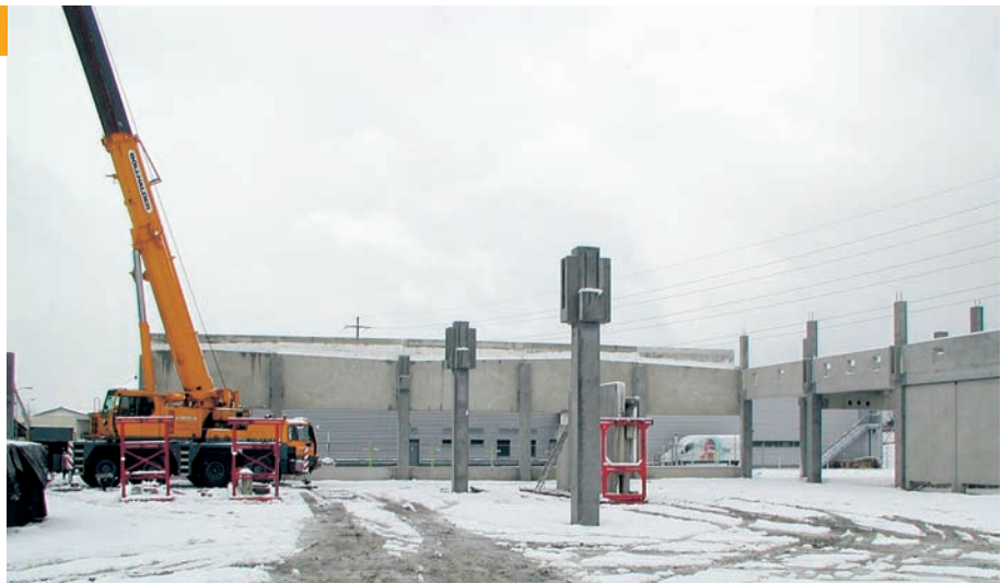
Zur Erdbebensicherung sind die Stützenfundamente mittels Stahlbeton-Zerrbalken untereinander verbunden.
